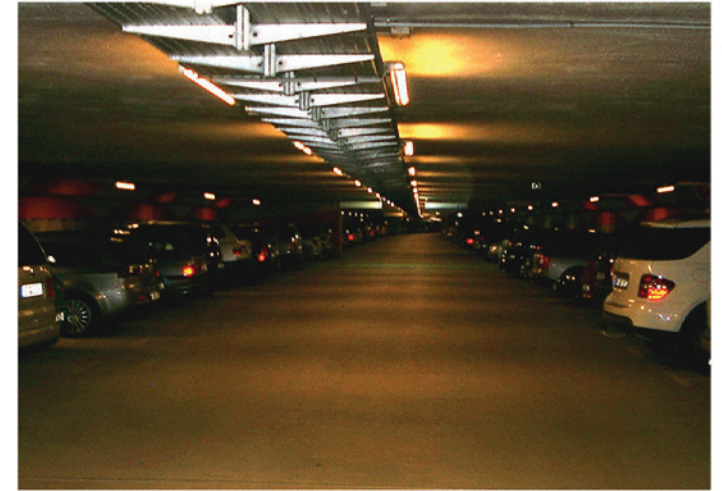
Innenansicht Tiefgarage Fürstenried West
